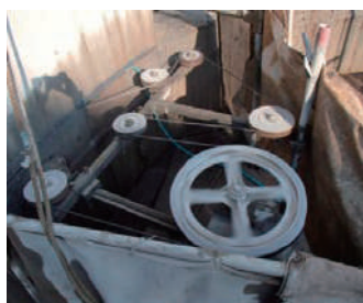
ワイヤーソーによる解体工事
