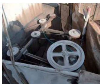
ワイヤーソーによる解体工事
