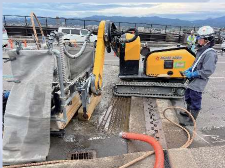
床版上面はつり
