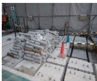
連続コアによる解体工事
