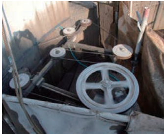
ワイヤーソーによる解体工事
