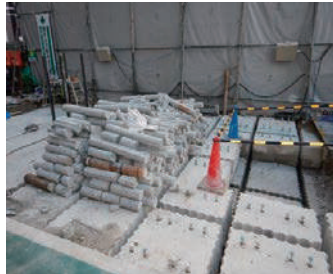
連続コアによる解体工事
