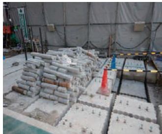
連続コアによる解体工事
