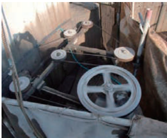
ワイヤーソーによる解体工事
