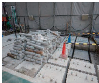
連続コアによる解体工事
