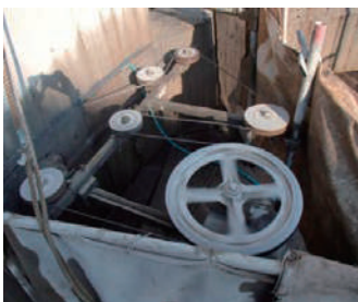
ワイヤーソーによる解体工事
