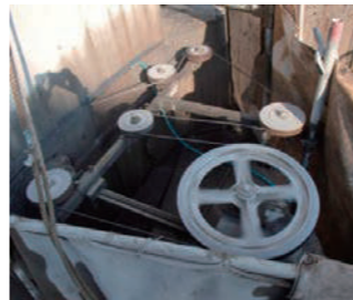
ワイヤーソーによる解体工事
