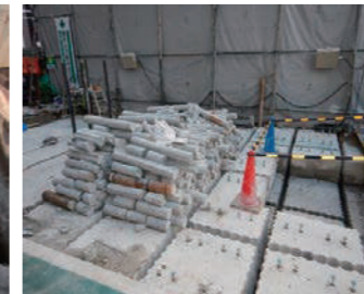
連続コアによる解体工事
