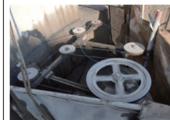
ワイヤーソーによる解体工事
