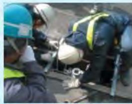
専用治具によるレールのセット
