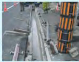
レール取り外し、切断部撤去
