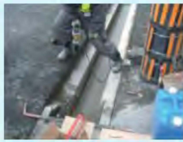
アンカー筋部削孔
