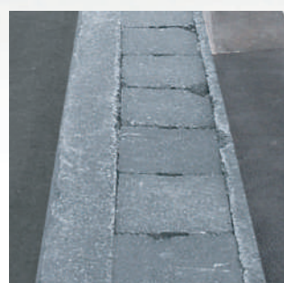
①既存側溝
