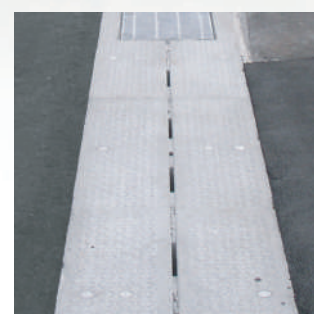
④施工完成
