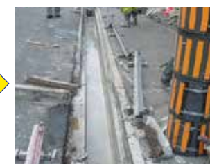
⑦レール取り外し・切断部撤去
