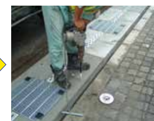
⑪アンカー筋削孔・固定
