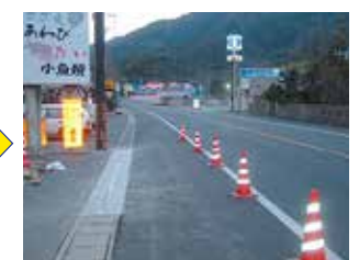
⑫施工完了
