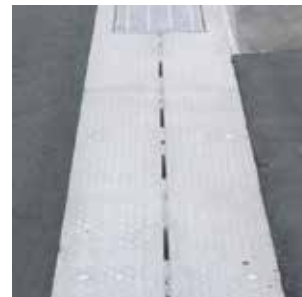
④施工完成
