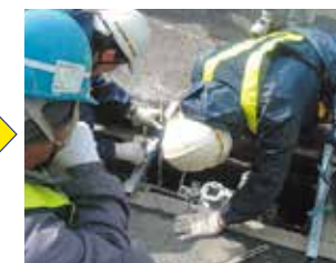
③専用治具によるレールセット
