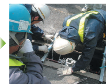
③専用治具によるレールセット
