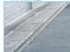
■ 改修前側溝蓋
