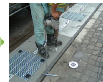
⑪アンカー筋削孔・固定
