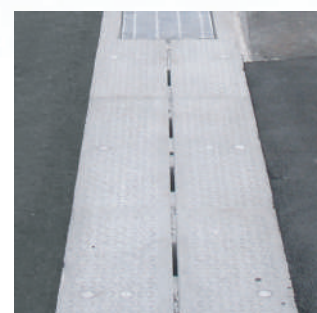
④施工完成
