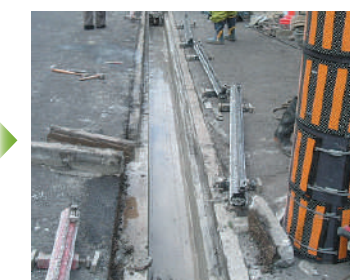
⑦レール取り外し・切断部撤去
