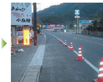
⑫施工完了
