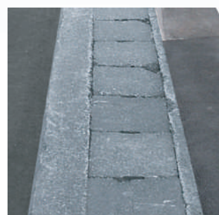
①既存側溝
