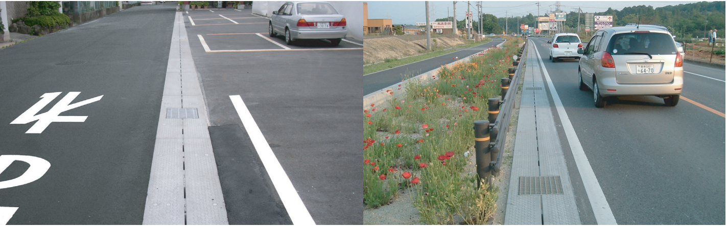
施工後 市道 31346 号線補修工事（静岡県伊豆市） 施工後（愛知県豊田市）
