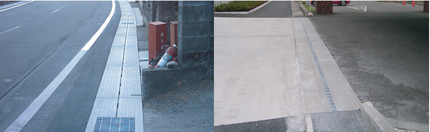
施工後 山手線（静岡県清水市） 施工後（愛知県北名古屋市）
