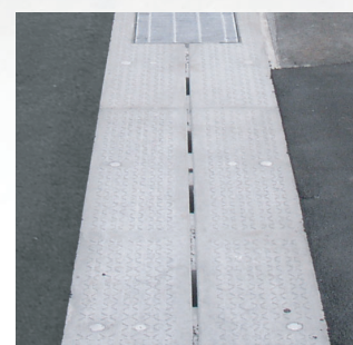
④施工完成
