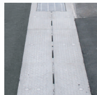
④施工完成
