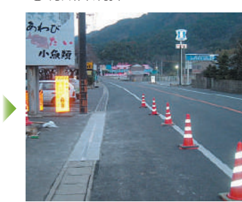
⑫施工完了
