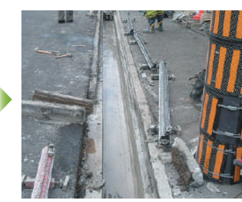
⑦レール取り外し・切断部撤去
