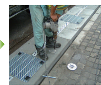
⑪アンカー筋削孔・固定
