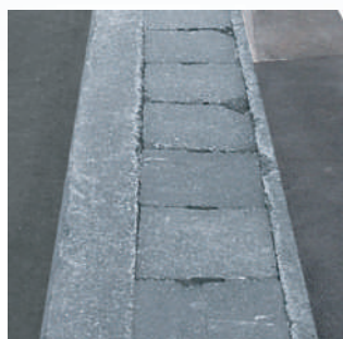
①既存側溝
