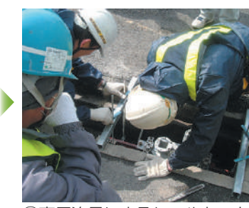
③専用治具によるレールセット
