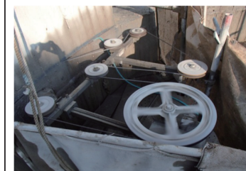
ワイヤーソーによる解体工事
