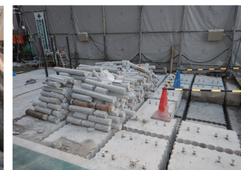
連続コアによる解体工事
