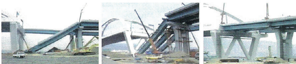
施工データは、ナガタ工業(株)提供によるものです。
