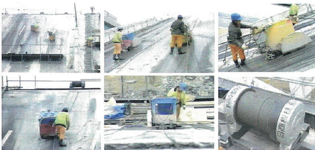
コンクリートカッター高斜度床版部切断 走行補助にウインチ使用
