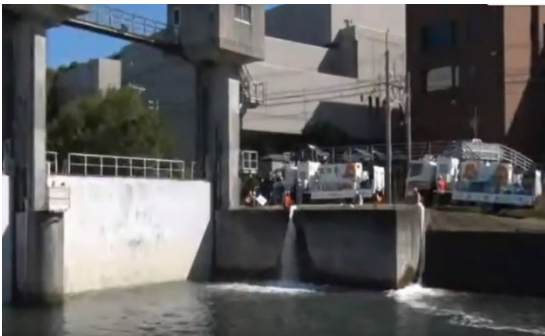
和歌山県及び国土交通省により排水ポンプ車配置
