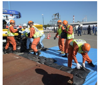
NEXCO西日本(株)関西支社による段差修正作業
