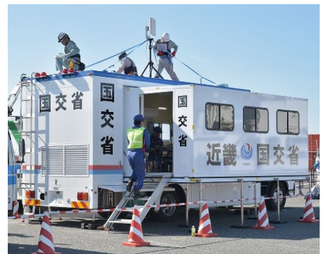
国土交通省対策本部車 車両上にi-RAS設置
