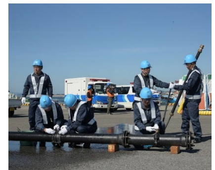
漏水している水道管の復旧作業
