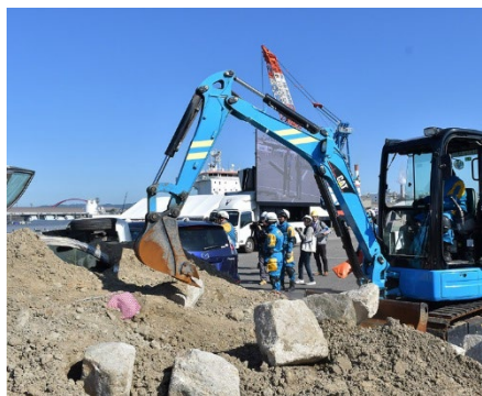
ショベルカーによる障害物除去作業
