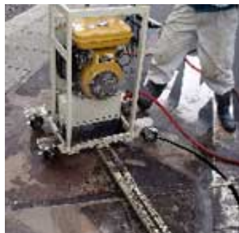
マンホール更新切断
