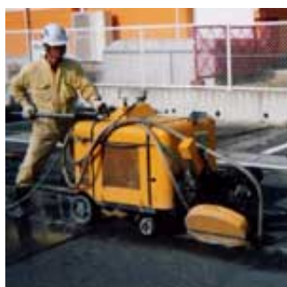
アスファルト舗装版 影響部分斜め切断
