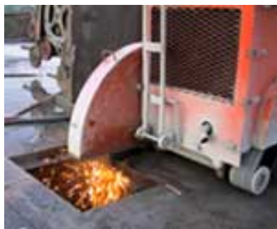
コンクリート床版切断
