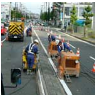
アスファルト舗装版切断 ステップカット工法
