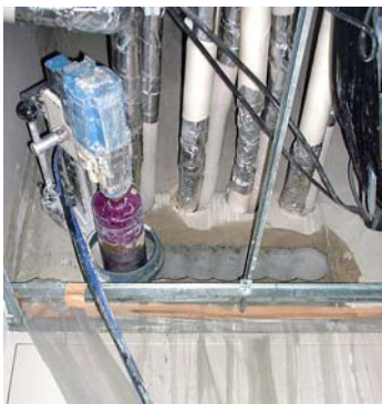
建築：設備工事
