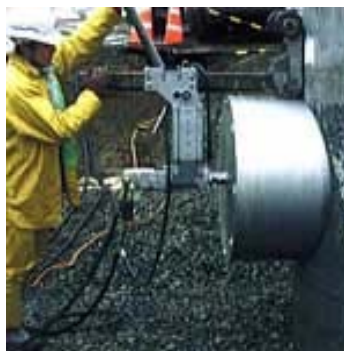
土木：改修工事
